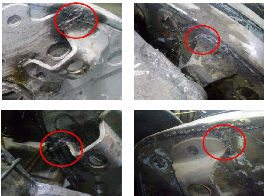
Рис. 1. Места наиболее частого образования трещин в районе узла фиксации кожуха зубчатой передачи остова тягового электродвигателя
