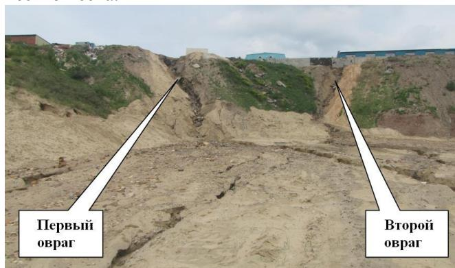
Рис. 1. Вид оврагов на склоне (откосе, песчаного карьера в полосе отвода железной дороги
