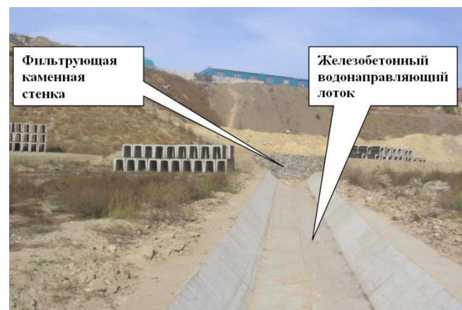
Рис. 2. Вид на фильтрующую каменную стенку (недостроенную), предусмотренную проектом выше входного сечения железобетонного водонаправляющего лотка с верховой стороны от моста
