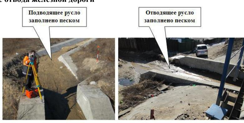
Рис. 4. Подводящее и отводящее русло железнодорожного моста: а) подводящее русло, б) отводящее русло
