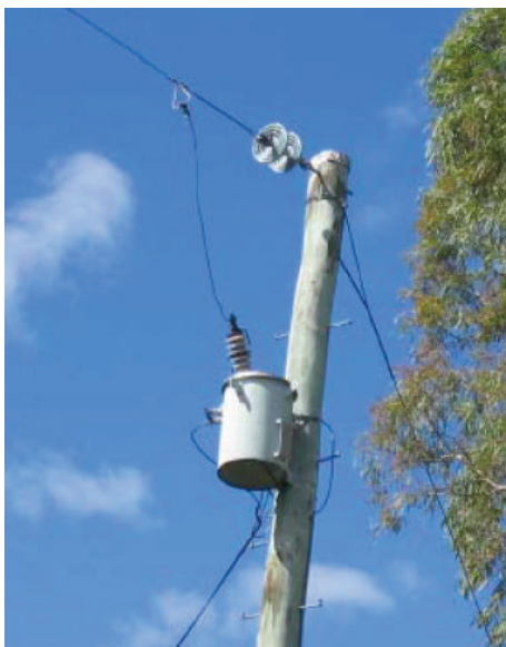
Рис. 1. Конструктивное исполнение ЛЭП «провод – земля» [4]
