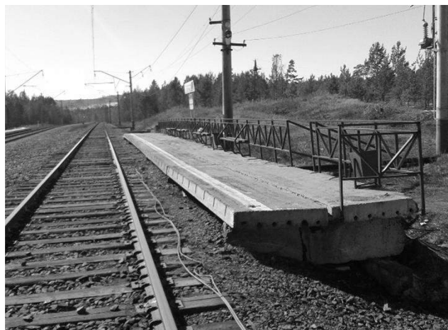
Рис. 2. Плитная платформа на бетонных блоках
