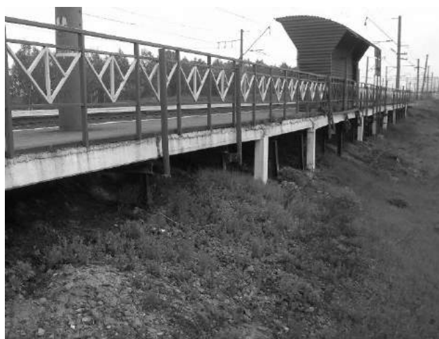
Рис. 3. Каркасная платформа на сваях
